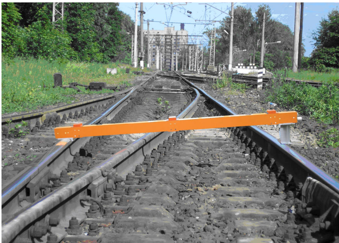
Рисунок 18. Установка БИПКП на рельсы в зоне подхвата отходящей ветви воздушной стрелки.
